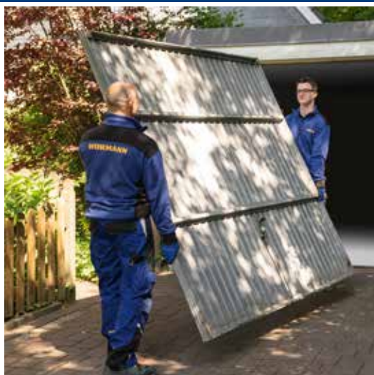
Ausbau und umweltgerechte Entsorgung
